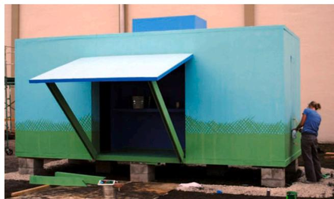
material de composição do abrigo não é madeira comum como vendido em materiais tradicionais de construção, é composto por tecnologia empregadas na indústria de aviação e de moinhos, conta com painéis isolantes autoportantes de até 4 polegadas compondo o sistema com revestimentos estruturais de tecido de vidro embebido com ruma resina epóxi polimérica resistente ao fogo.
